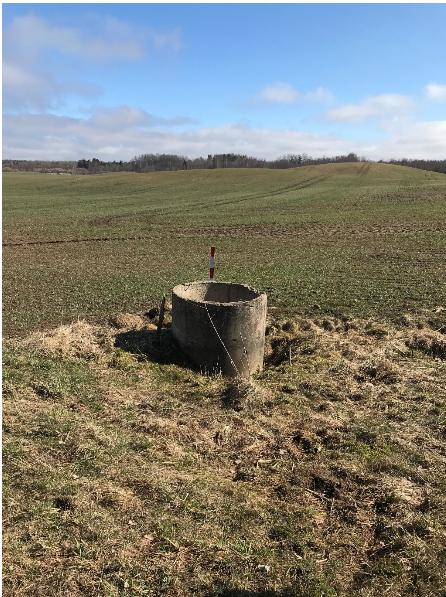
14. attēls. Meliorācijas sistēmas funkcionalitātes traucējumi, ID 6.
