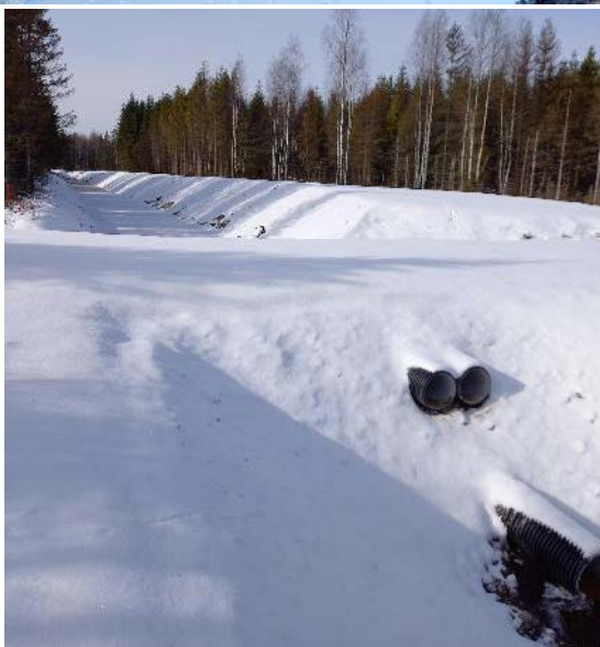
6. attēls. Maksimālās caurplūdes kontroles struktūra nelielā MMS Zviedrijā (pa kreisi) un lielā MMS Latvijā, Zinātniskās izpētes mežos (pa labi)
