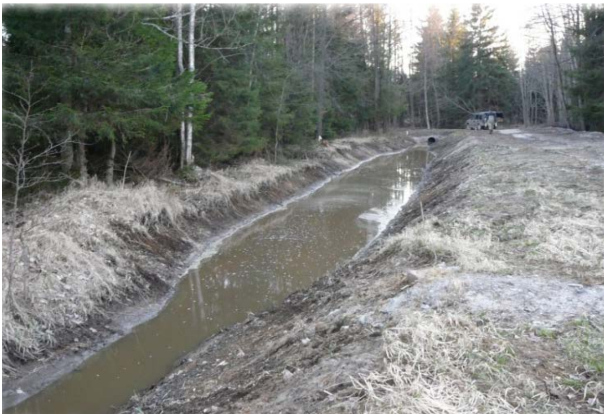
7. attēls. Standarta konstrukcijas sedimentācijas dīķis Latvijā
