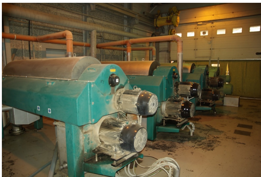
9.attēls. Lieko dūņu blīvēšanas dekantercentrifūgas.
